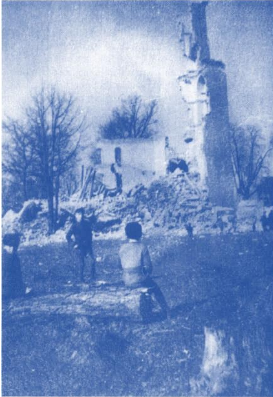
Rest des Schlosses Seerhausen nach der ersten bzw. vor der zweiten Sprengung von Süden her gesehen, Januar 1948.
