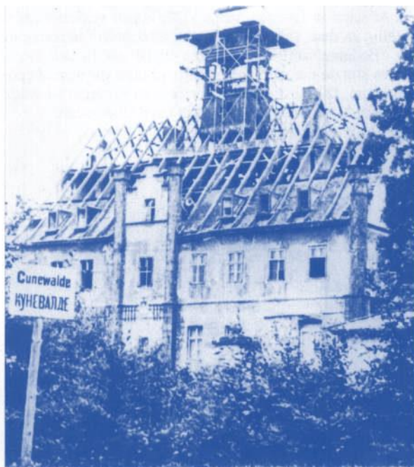
Schloss Obercunewalde Nach dem Beginn und während des Abrisses 1949.
