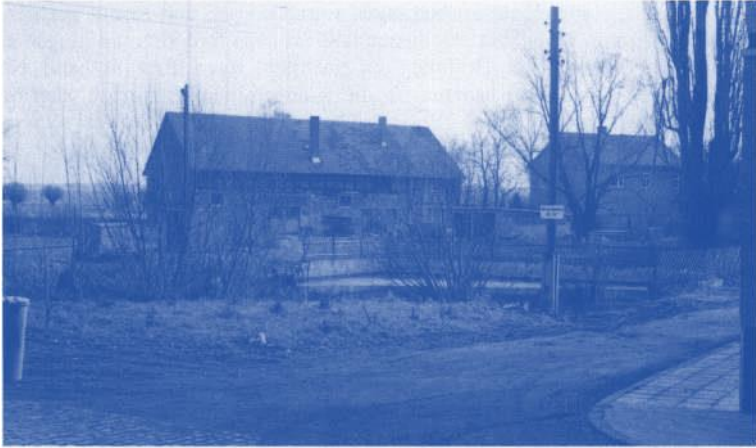
Januar 1990: Schloss abgerissen, vorne Rest der zugeschütteten Gracht, eine statt früher fünf Pappeln, Inspektorhaus.
