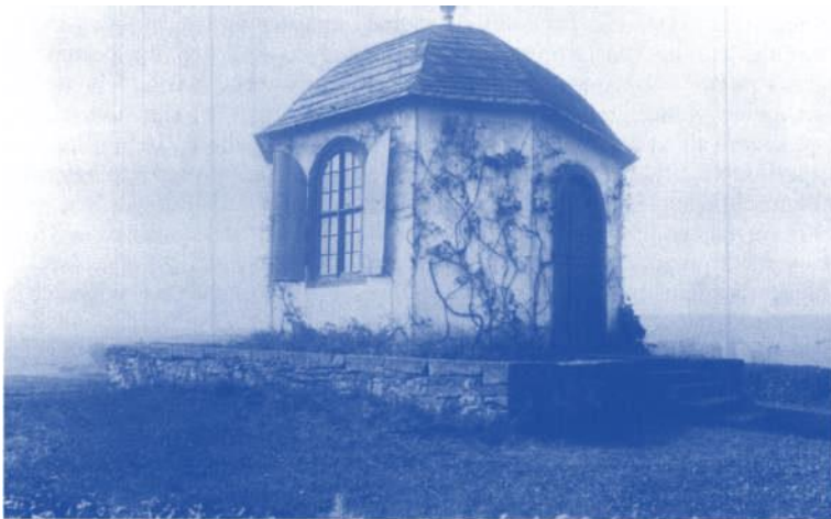
Kleitschhaus oder das «Wahrzeichen von Lausnitz»
